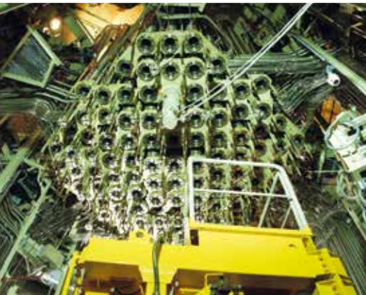
▲ Механизм управления стержнями на дне резервуара высокого давления внутри реактора
